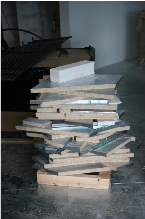
Chutes de découpe de dalles de sols sur chantier. 5ème étage, rue Orban, Ixelles, mai 2012
