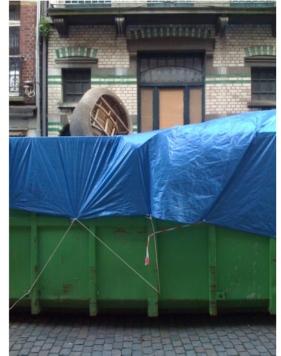
Dépôt clandestin à même la bâche de couverture - Bruxelles
