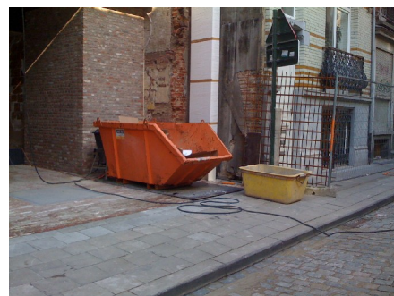
Une benne métallique de chantier et un bac à mortier en HDPE
