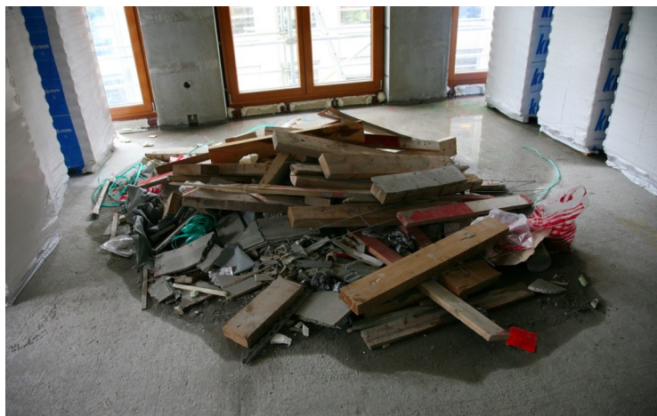
résidus de nettoyage sur un chantier : le tri fait sens
