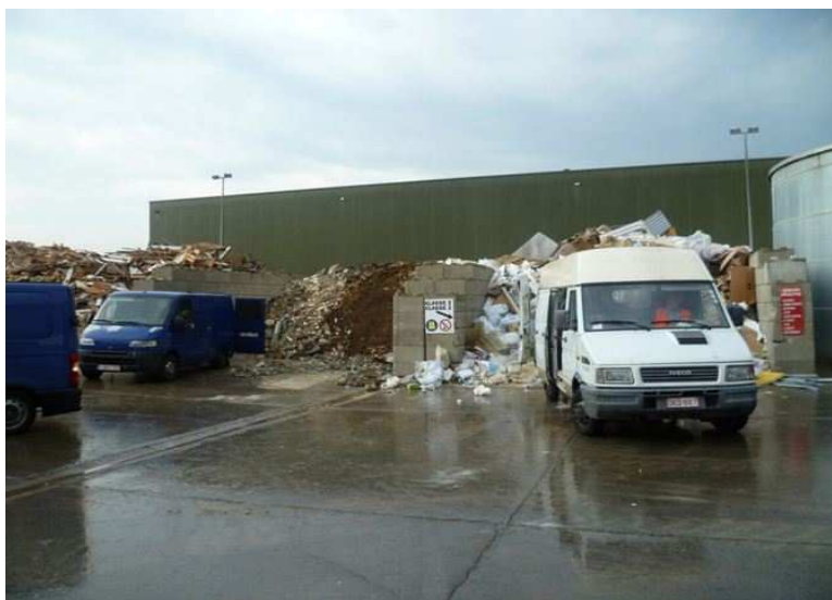
Illustration 58 : Dépôt sur trois tas de regroupement : bois, inertes et mélange.
