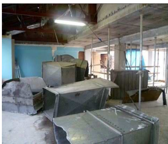
Illustration 77 : A) AIB a démonté les dalles de moquette. Une partie d'entre elles ont été utilisées pour protéger l'escalier, qui devait rester intact dans la rénovation du bâtiment – B) AIB a également démantelé toutes les installations HVAC du bâtiment
