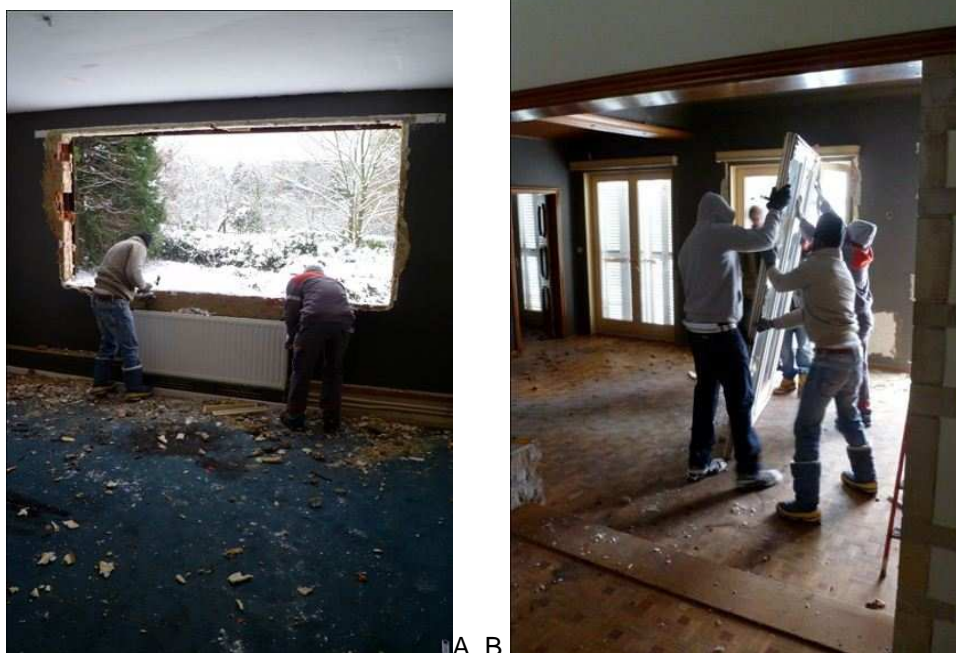
Illustration 76 :A) Démontage "à l'amiable" de radiateurs dans un chantier de démolition – B) Démontage "à l'amiable" de châssis dans un chantier de démolition
