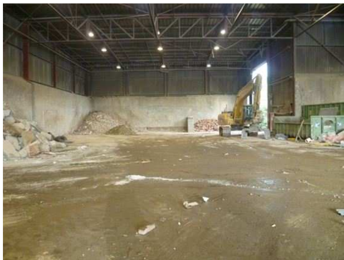
Illustration 59 : Le hangar où s'effectue le tri à la pelle hydraulique
