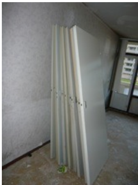
Bouwcarrousel NV (NL) démonte les éléments réutilisables avant la démolition des parties structurales. L'équipement se limite à quelques outils et une visseuse par ouvrier.
