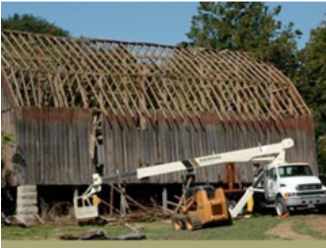
Elmwood SA (Kansas City, US) récupère du bois dans des démolitions divers. Les bâtiments sont démantelés étage par étage, et les matériaux sont préparés au transport.
