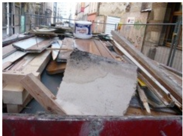
Les déchets de démolition et prédémolition contiennent une partie considérable de bois réutilisable, même si les techniques assez brutes ont été utilisées lors des travaux.
