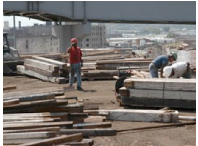
Elmwood SA (Kansas City, US) récupère du bois dans des démolitions divers. Les bâtiments sont démantelés étage par étage, et les matériaux sont préparés au transport.
