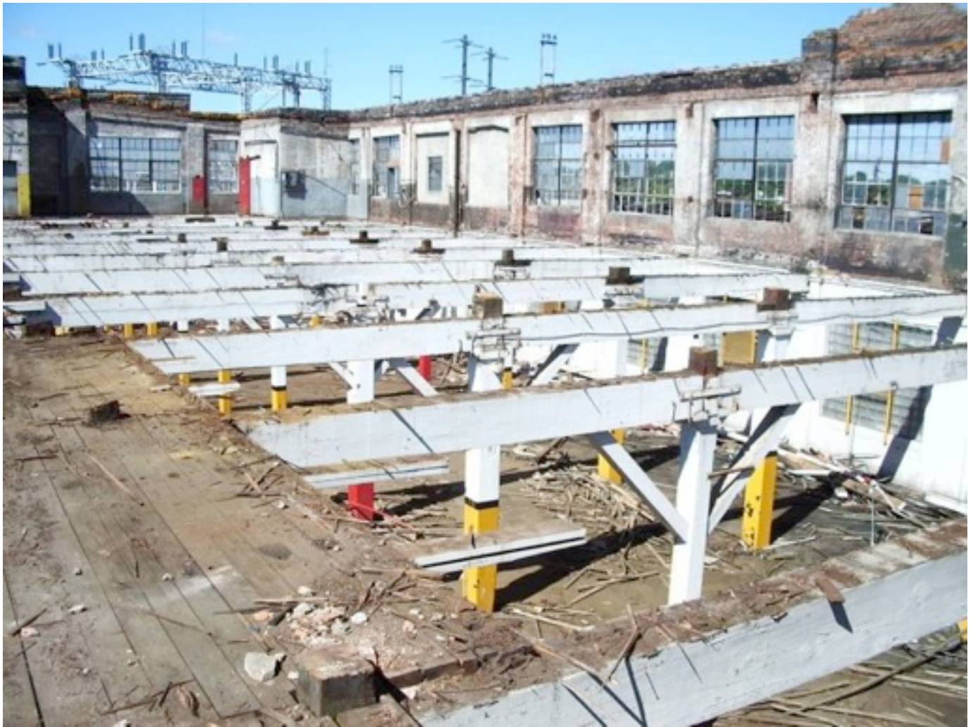
Exemple d'un chantier de déconstruction totale lente en Etats-Unis (images Dallas Contracting Co.)
